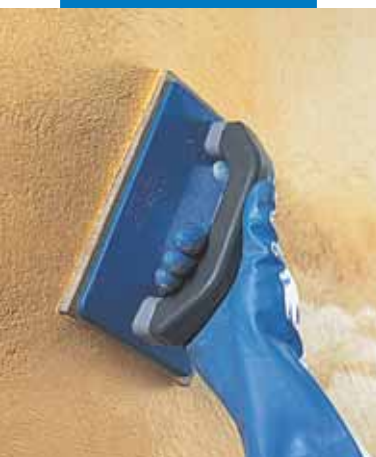
Silexcolor Tonachino virsmas izlīdzināšana ar rīvdēli
