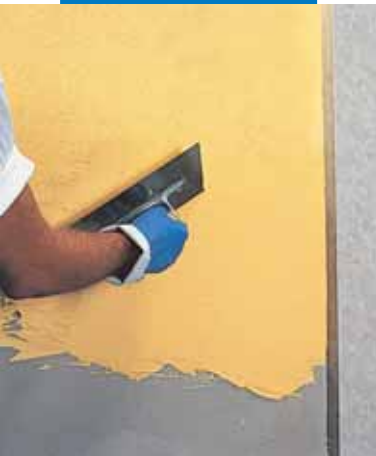
Silexcolor Tonachino uzklāšana ar apmetuma ķelli
