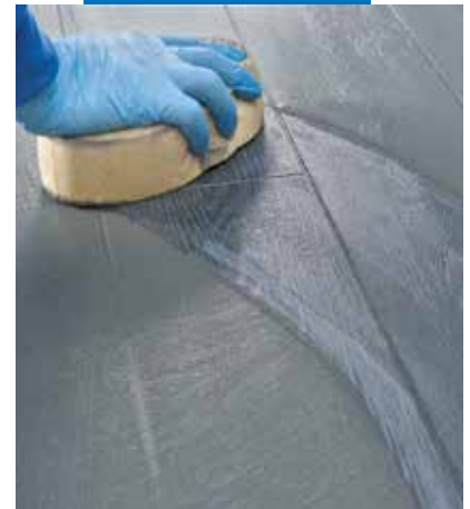
Virsmas tīrīšana un noslédzošā apdare, izmantojot cietu celulozes sūkli
