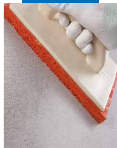
Izlīdzinošā slāņa virsmas apstrāde ar sūkļa rīvdēli
