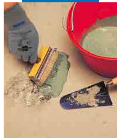
Bojāto vietu apstrāde grīdās ar cementa - Planicrete gruntēšanas sastāvu
