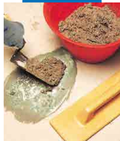
Bojājumu novēršana ar javu, kas modificēta ar Planicrete
