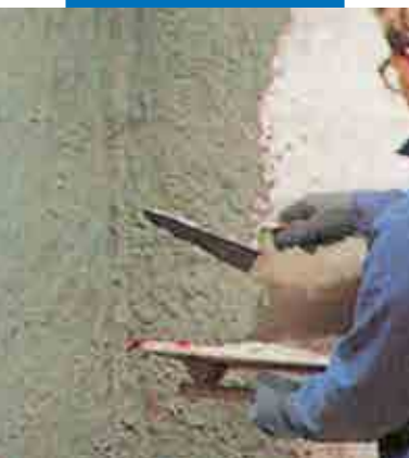
Ar Planicrete modificētas apmetuma javas uzklāšana
