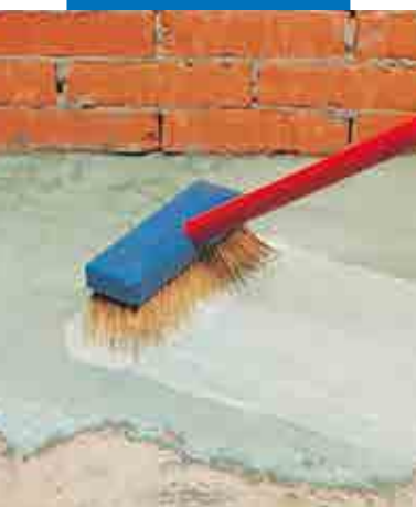
Pamatnes apstrāde ar gruntēšanas sastāvu, kas izgatavots no cementa un Planicrete
