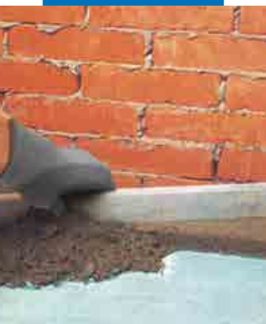
Grīdas plāksnes izveide no betona, kas modificēts ar Planicrete
