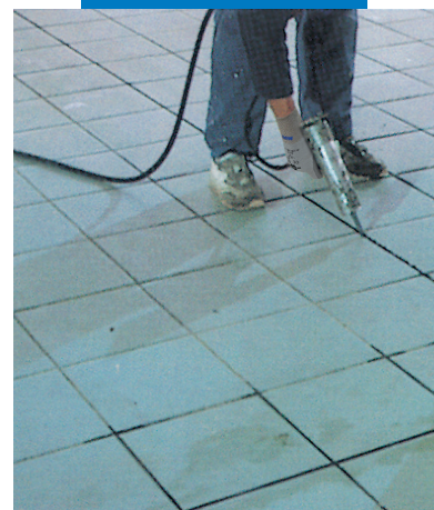
Keramisko flīžu klājuma šuvju aizpilde grīdām
