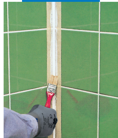
Aizpildītās šuves virsmas izlīdzināšana ar ūdeni samitrinātu otiņu
