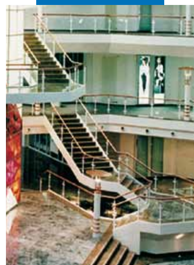
Keramisko vai marmora klājumu izveide uz metāla konstrukcijām (kāpnes)
