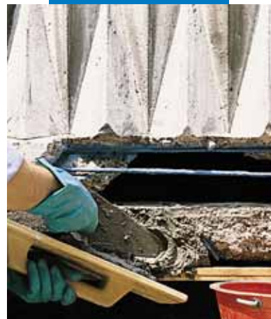
Balkona remonts, izmantojot Mapegrout T40
