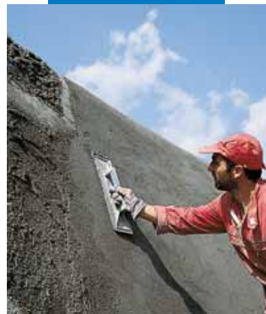
Mapegrout T40 uzklātās remontjavas virsmas izlīdzināšana
