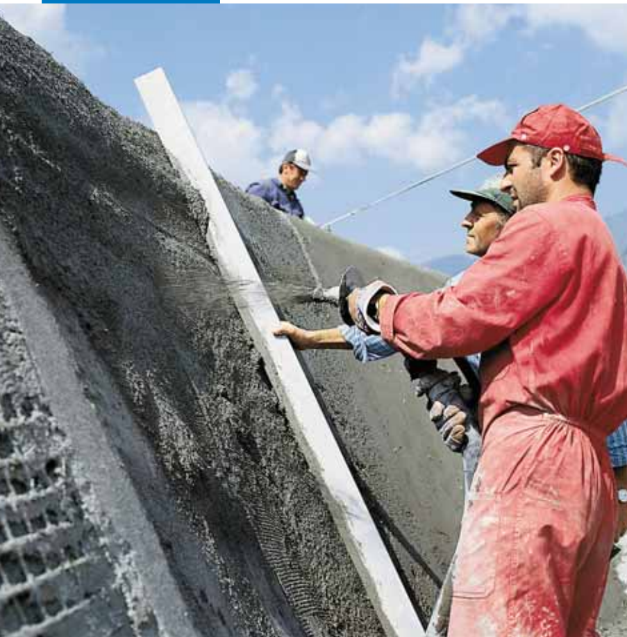
Mapegrout T40 uzklāšana, izmantojot torkretēšanas iekārtu
