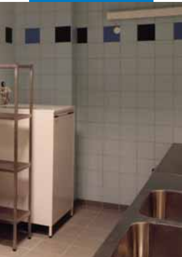
Flīžu klājums izveidots uz virsmas, kura pirms tam apstrādāta ar Primer S - Olomok slimnīca - Čehija
