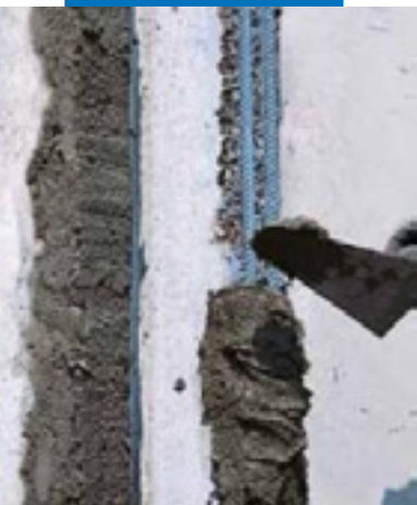
Нанесение раствора мастерком
