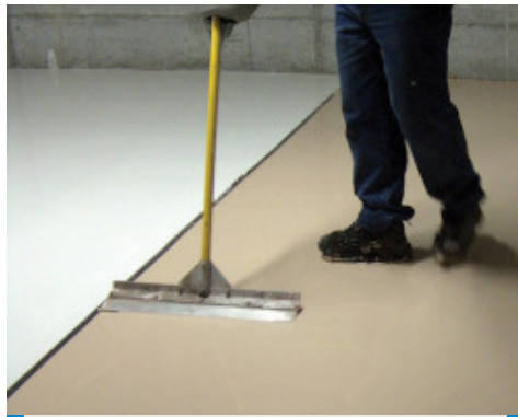
Ultratop slāņa izlīdzināšana nekavējoties pēc uzklāšanas
