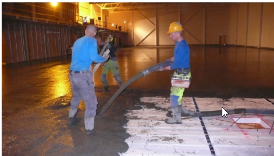
Mapecrete System grīdas izveide bez šuvēm 1300 m 2 platībā
