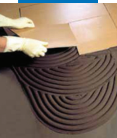
Укладка керамогранита на гидроизоляцию Mapelastic
