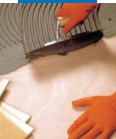
Укладка керамогранита на судостроительную фанеру с применением Elastorapid
