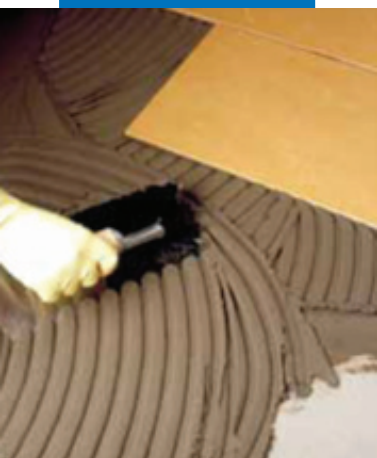
Нанесение Elastorapid на цементную стяжку посредством зубчатого шпателя
