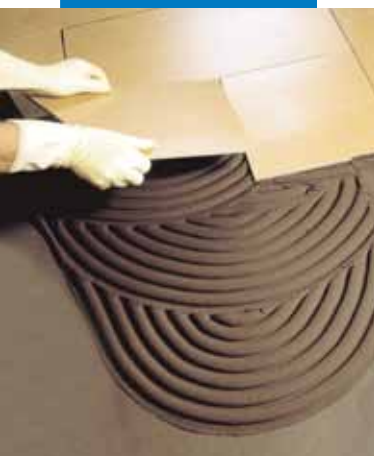
Porcelāna flīžu instalēšana uz pamatnes, kura apstrādāta ar Mapelastic hidroizolācijas sastāvu
