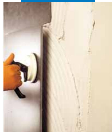
Liela izmēra porcelāna flīžu instalēšana uz betona fasādes ar Elastorapid
