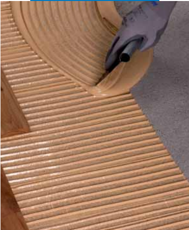
Masīvkoka parketa instalēšana uz pamatnes, kas izveidota izmantojot Topcem
