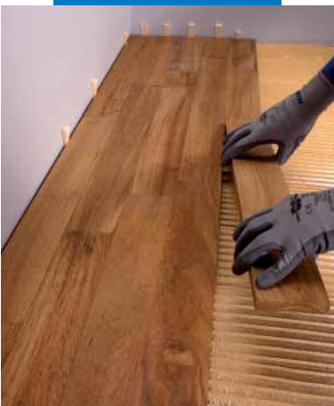
Lielformāta koka dēliņu instalēšana
