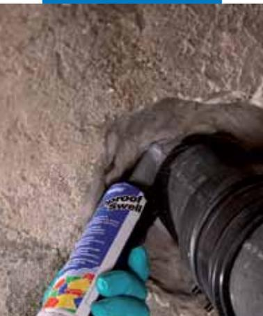
Герметизация элемента при помощи Mapeproof Swell
