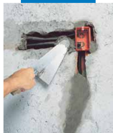
Elektrisko kabeļu fiksācija un pārklāšana ar Lampocem
