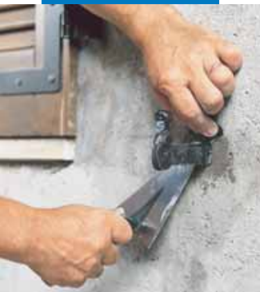
Metāla detaļu nostiprināšana ar Lampocem
