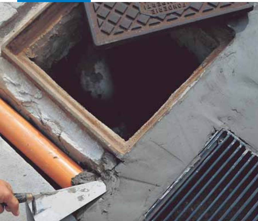
Cauruļu nostiprināšana un pārklāšana ar Lampocem
