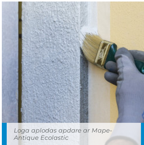
Sienas dekoratīvā elementa hidroizolācija ar Mape-Antique Ecolastic
