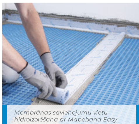
Mapeguard UM 35 ieklāšana
