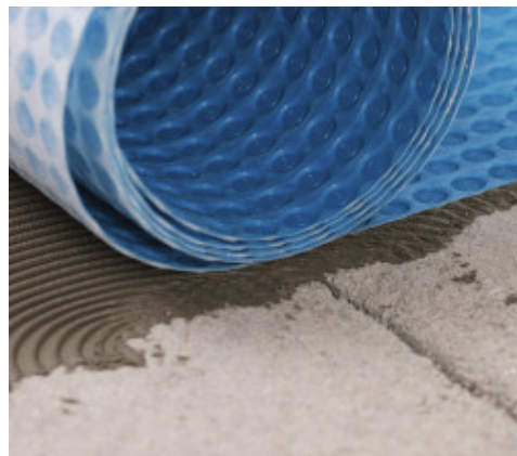
Mapeguard UM 35 ieklāšana
