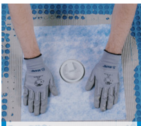
Noteku hidroizolēšana ar Drain Vertical/Drain Lateral
