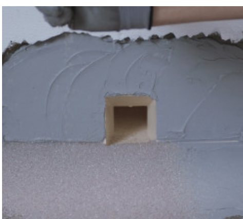
Notekas hidroizolēšana ar Drain Front
