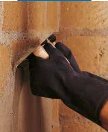
Pirmā Planitop HDM Maxi slāņa uzklāšana
