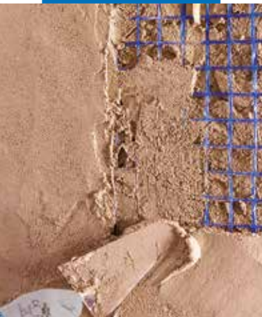
Otrā MapeWall Render&Strengthen slāņa uzklāšana
