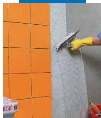
Keramisko flīžu klājuma izveide uz MapeWall Render & Strengthen slāņa
