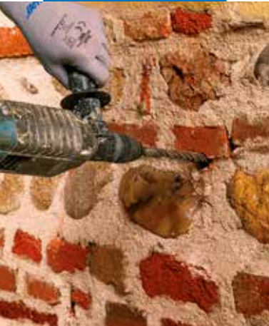
Urbumu izveide Mapenet EM Connector instalēšanai
