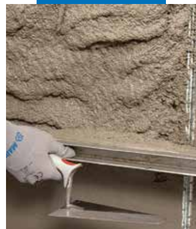
MapeWall Render & Strengthen slāņa izlīdzināšana
