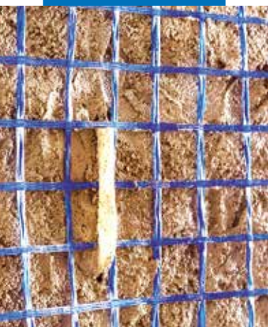
Placing Mapenet EM 40
