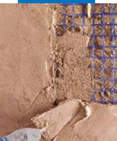
Нанесение второго слоя MapeWall Render & Strengthen
