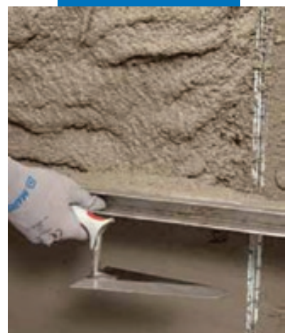
Нанесение MapeWall Inject & Consolidate гладилкой
