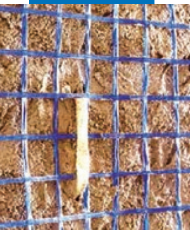
Нанесение MapeNet EM 40
