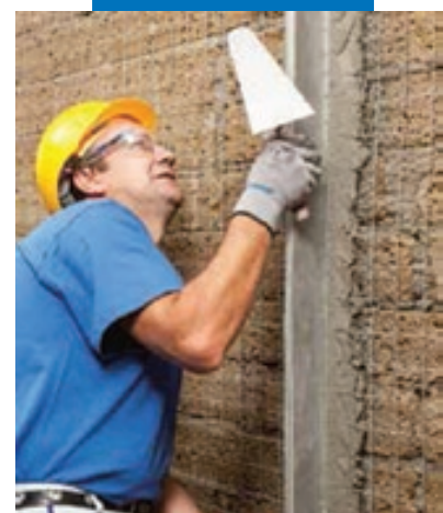
Проверка перпендикулярности направляющих
