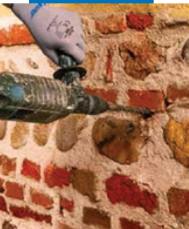
Подготовка отверстий в стене к нанесению MapeNet EM Connector
