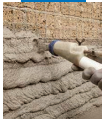
Нанесение MapeWall Render & Strengthen с помощью штукатурного агрегата
