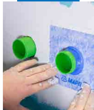
Mapeguard WP System detaļas ielīmēšana sienas atverēs, izmantojot Mapegum WPS
