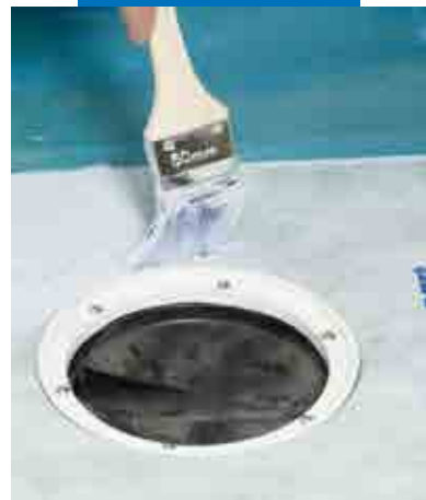
Drain Vertical detaļas pielīmēšana, izmantojot Mapegum WPS
