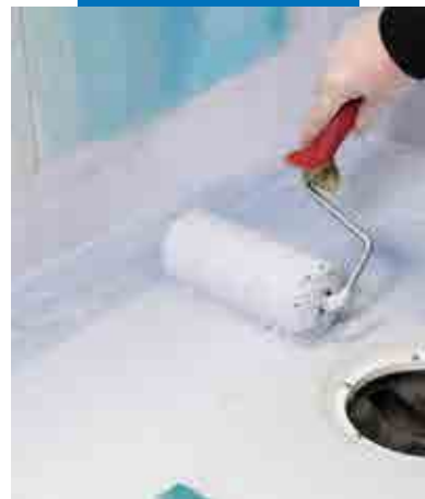
Drain Vertical detaļas pielīmēšana, izmantojot Mapegum WPS
