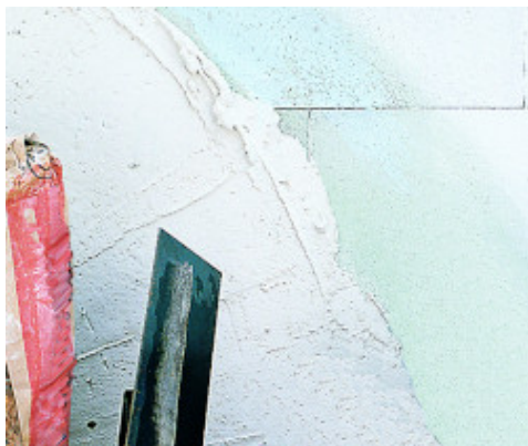
Virsmas gruntējums pirms ģipša apmetuma uzklāšanas
