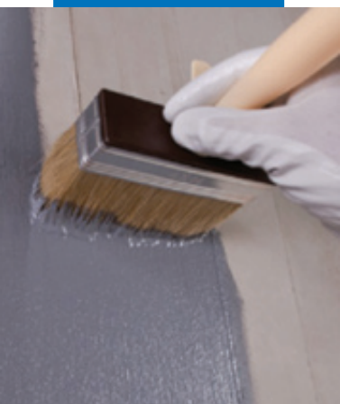
Нанесение Eco Prim Grip на бетон с помощью кисти
