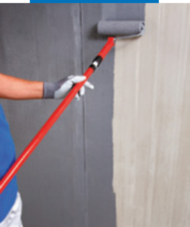
Нанесение Eco Prim Grip на бетон с помощью валика
