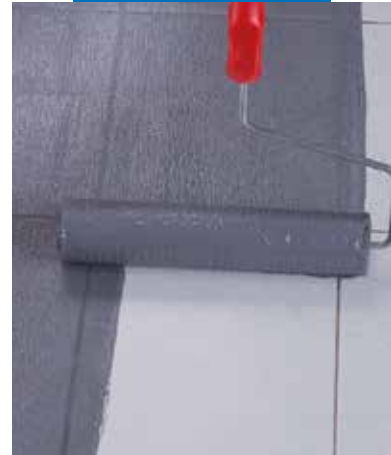
Eco Prim Grip Plus uzklāšana izmantojot rullīti uz esoša porcelāna flīžu klājuma
