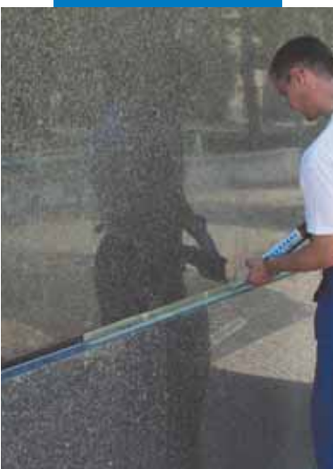
Fasādes šuvju aizpilde ar Mapesil LM
