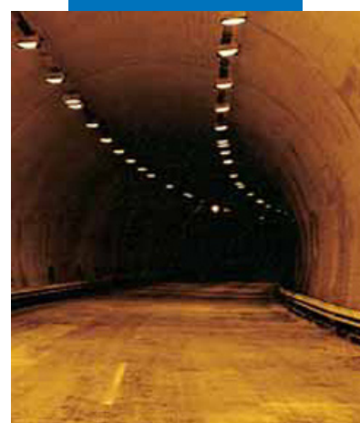
Нанесение белого Planiseal 88 напылением в автодорожной галерее
