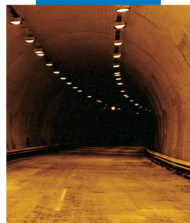
Planiseal 88 izmantošana autostrādes tuneļa izbūvē
