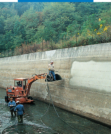
Uzklāšana uz dambja ar pulverizācijas metodi
