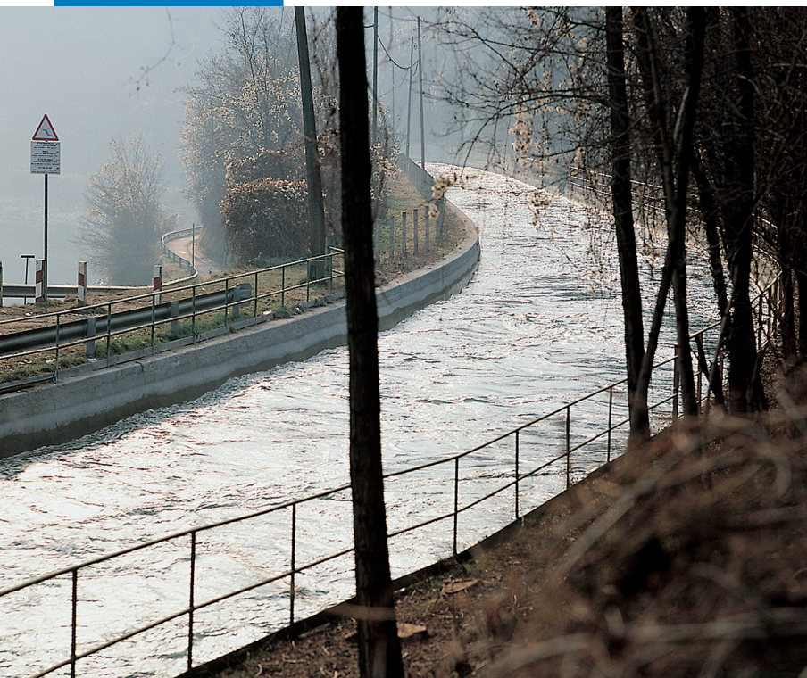
Kanāla Robbiate (CO) hidroizolācijas izveidei izmantots hidroizolācijas sastāvs Planiseal 88
